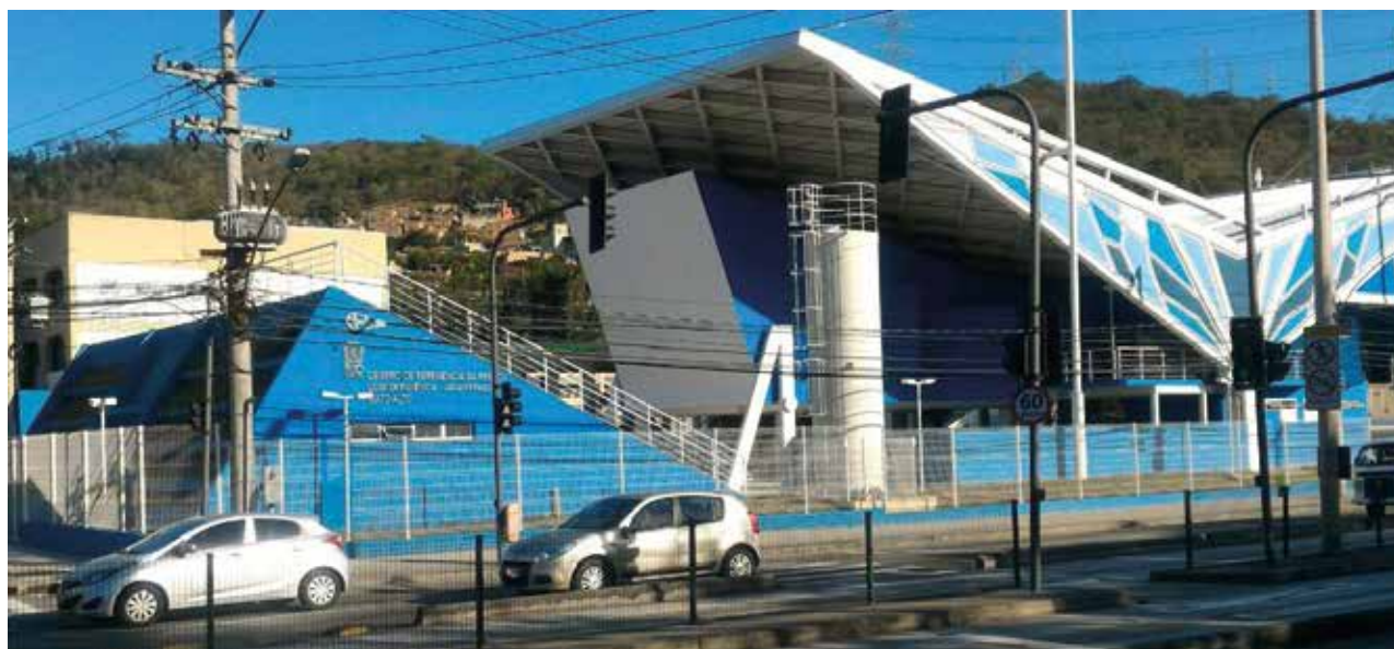
Centro de Referência para Pessoas com Deficiência (CRPD) de Jacarepaguá
