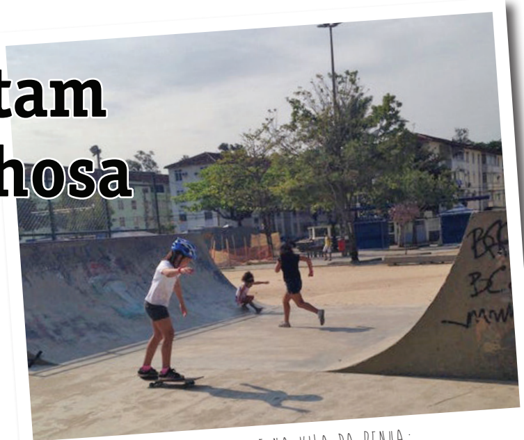
RAMPA DE SKATE NA VILA DA PENHA: TRANSIÇÃO DA RAMPA PARA O CHÃO FOI MAL ONSTRUÍDA.
